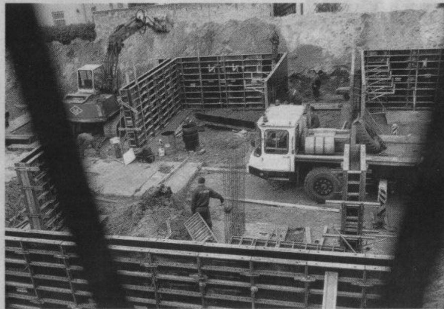
Między domkami jednorodzinnymi na Włochach wyrastają wysokie bloki komunalne
